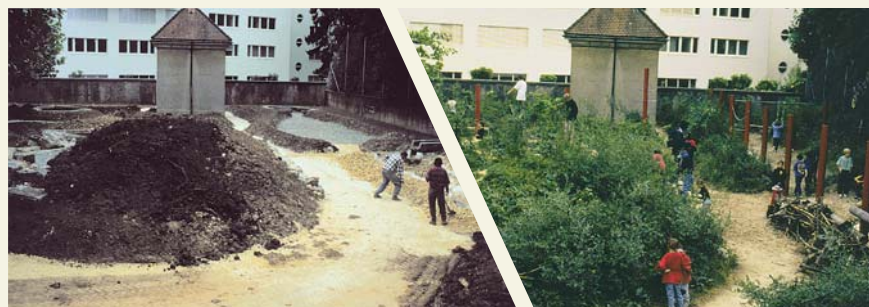
Spielanlage im Schulhaus – im Bau 1996 (Solothurn, Schweiz)
